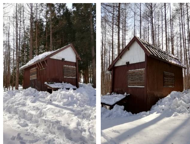
2月13日 造林小屋の雪下ろし完了
