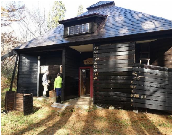
久しぶりに板壁全面に防腐剤塗りが完了！
