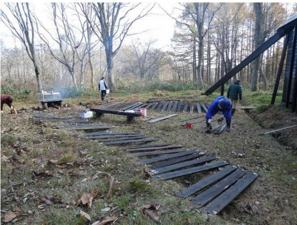
雪囲い板に防腐剤の塗布作業
