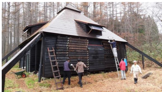
小屋締め作業する現役諸君！
