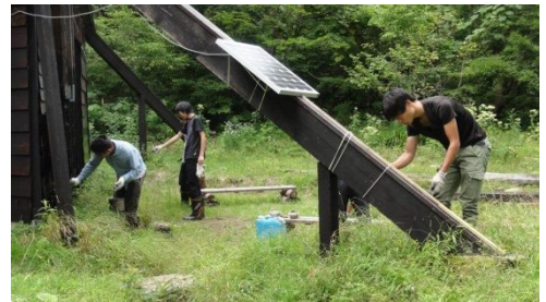
防腐剤を塗る現役達（9月）
