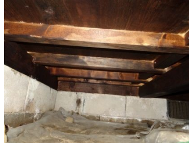
点検口右側(北側)防腐剤塗布
