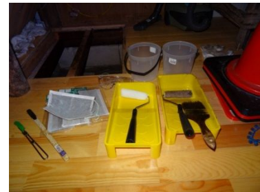
床下防腐剤塗りの新ツール！
