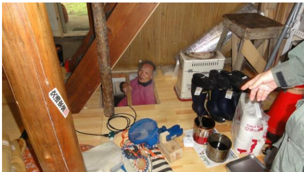
嘉納前会長床下防腐剤の陣頭指揮（10月）
