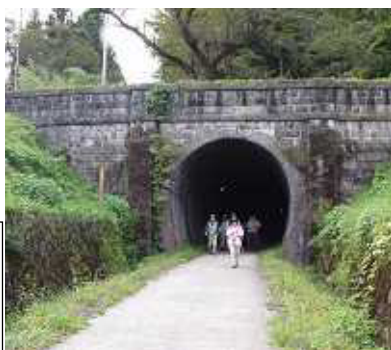
9月 遊歩道 アプトの道
