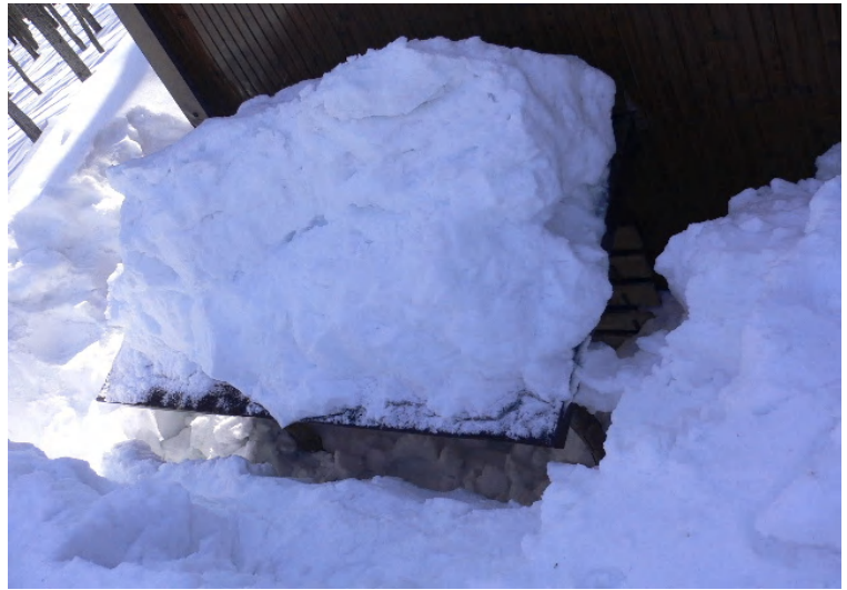
写真4：造林小屋庇の縁切り（庇を雪の上から見下ろした写真です） 周囲と切り離されていることが判ります。 庇の上にはまだ大きな氷の塊が残っていますがこれは大丈夫です。
