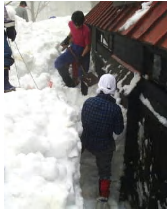
写真 14 雨戸の掘出し
