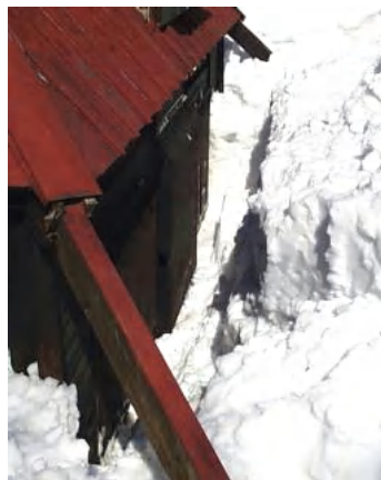
写真 17 雨戸除雪完了
