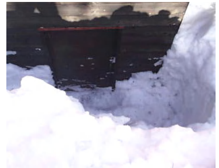
写真 18 倉庫除雪完了
