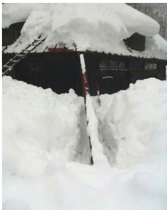
写真 16 柱除雪完了
