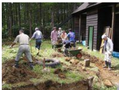
排水改良南側
