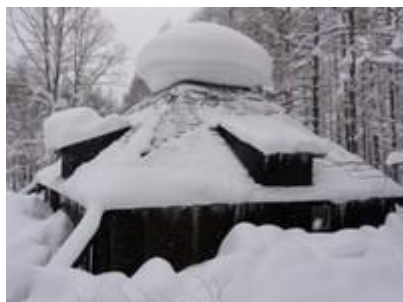
ストーブ7台で屋根を暖め落雪、1日後
