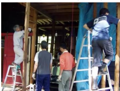
西面土台を取替え、新しい柱を立てる
