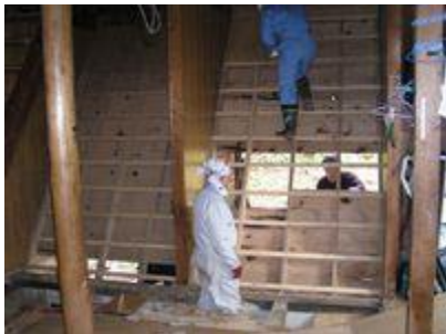
北面斜め壁取り壊し
