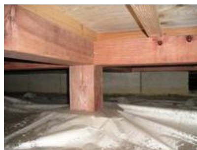
床下に水分侵入防止のビニールシート
