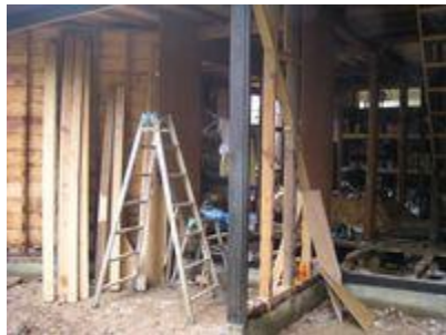
斜め壁を取り壊し終了
