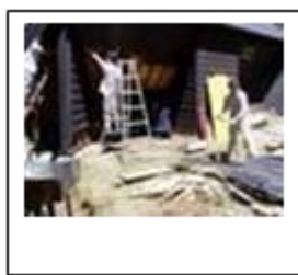
南西斜壁と土台撤去
