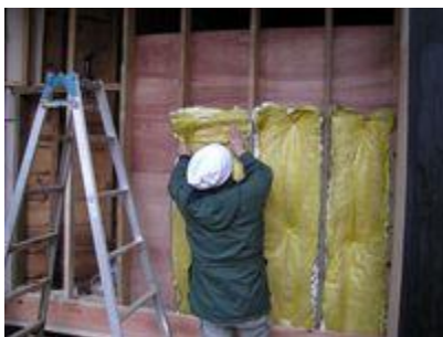
北側外壁 断熱材張り付け
