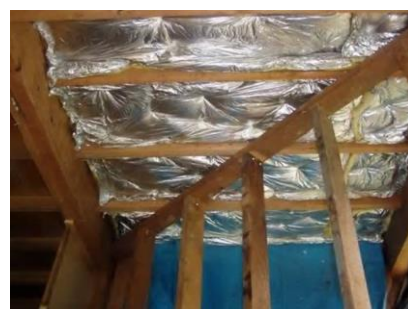
天井裏には断熱材を入れる
