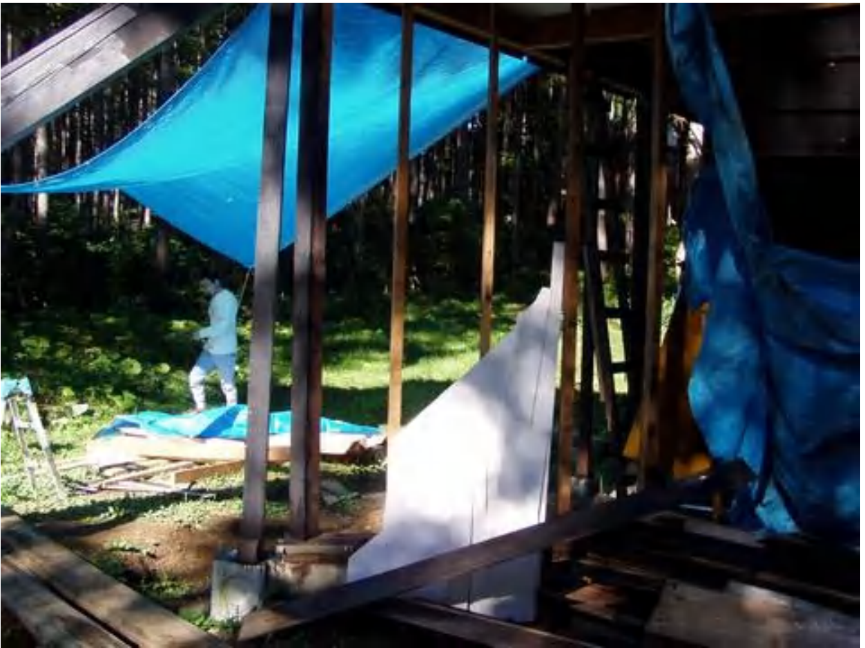
工事中の雨対策か？テント張りは、ワンダラーはお手の物
