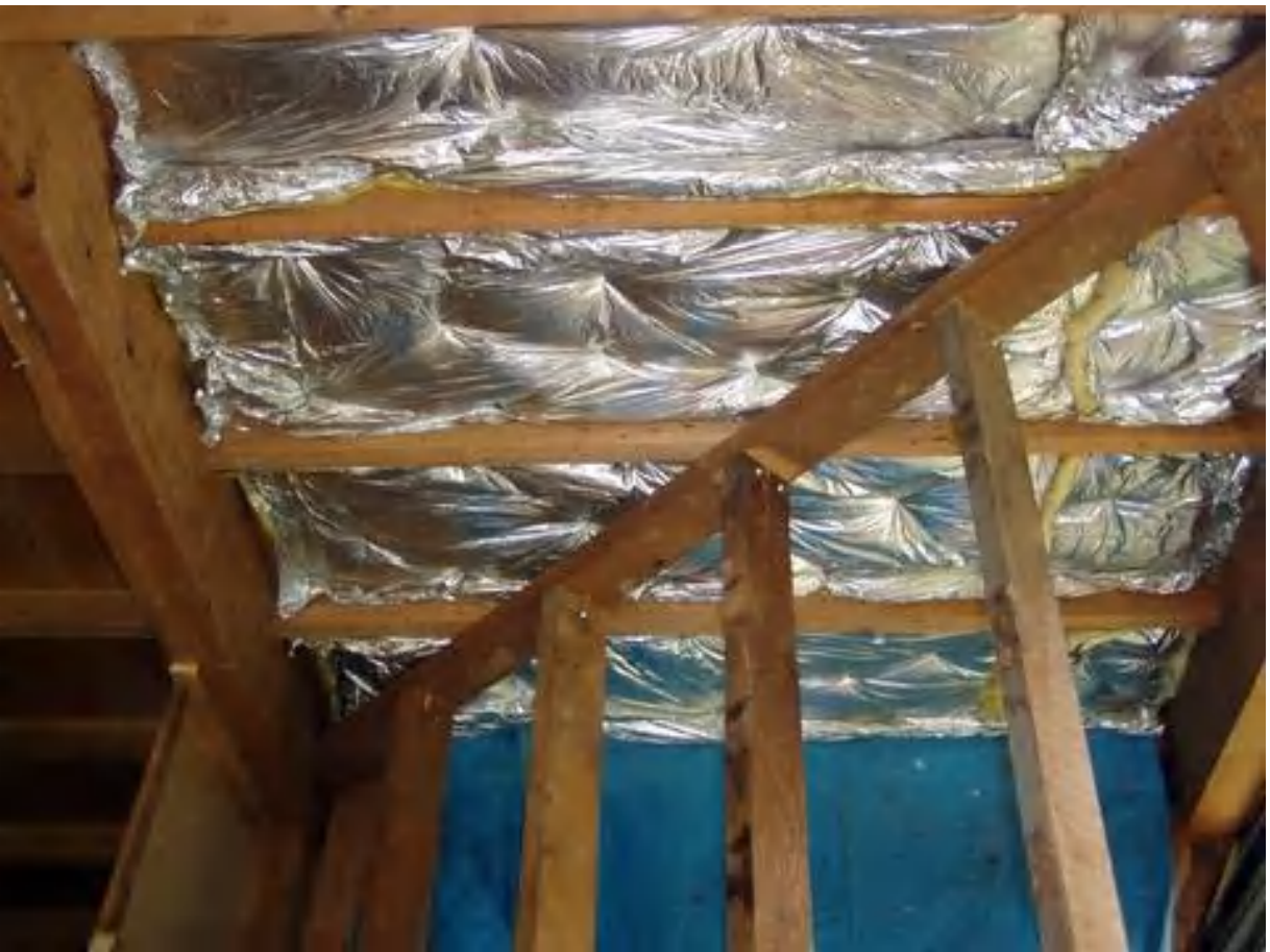
天井もしっかりと保温材を挟んで、厳冬期対策万全！！
