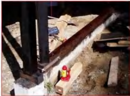
4 柱下土台を 自作金具で締結
