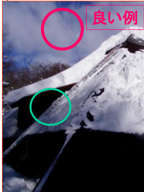
D:梯子中央継ぎ手は屋根にぴったり付ける
